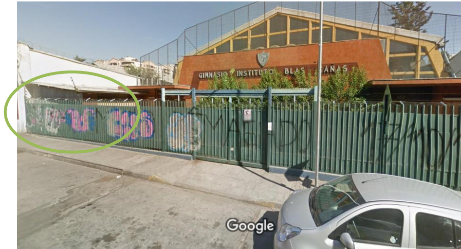
Acceso Principal de la Escuela Básica Blas Cañas por calle Blas Cañas y acceso a Gimnasio. Ambos accesos considerados como Salidas de Emergencias hacia Zona de Seguridad Externa. (Actualizar Foto)
