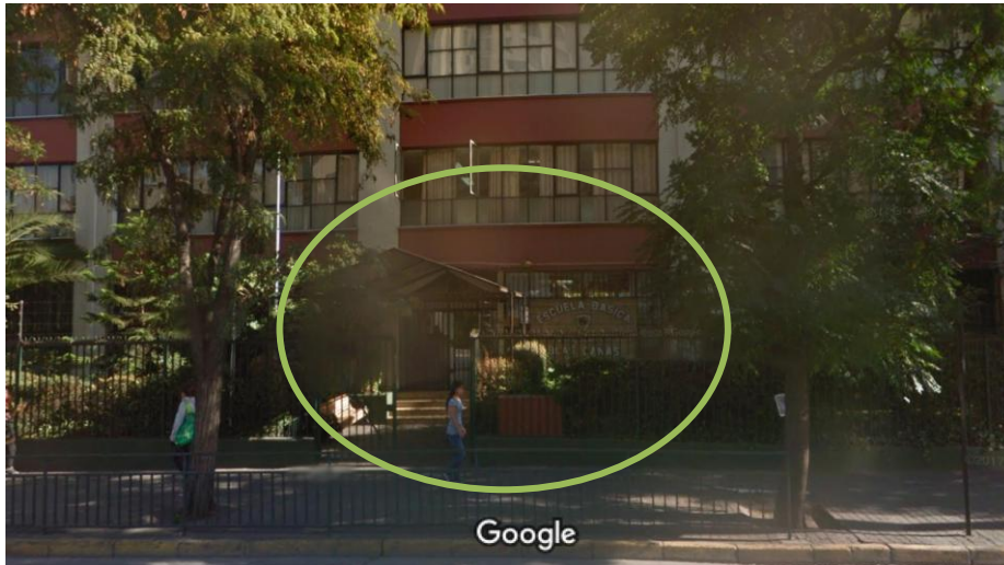
Acceso alternativo Escuela Básica Blas Cañas por calle Curicó, considerada como Salida de Emergencias. Alto tráfico por calle Curicó - Riesgo para la Comunidad Educativa.
